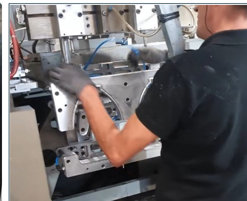
MONTAGE DU DECAROTTEUR MOBILE
